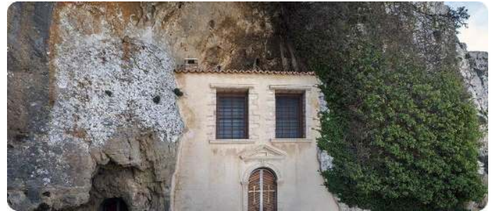
Die in den Fels gebaute Kirche des Klosters Faneromeni
